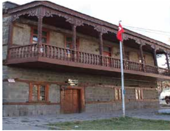
Osmanlı Dönemi sivil mimari eserlerinden Gazi Ahmet Muhtar Paşa Konağı
